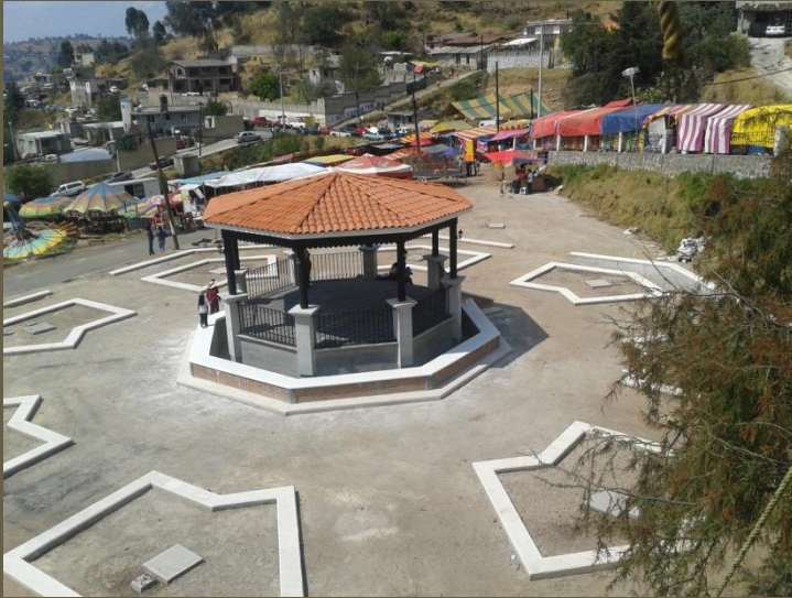
KIOSCO TECHADO Y TERMINADO
